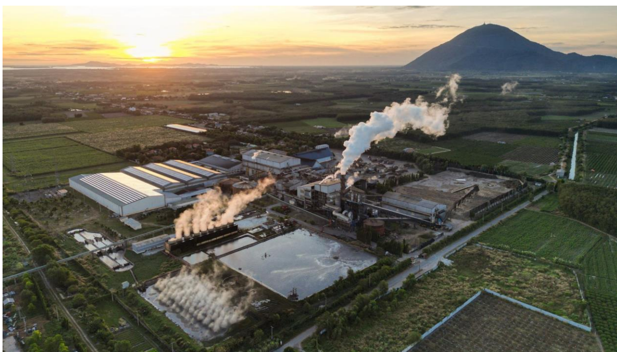
Hình 1. 3. Nhà máy đường thuộc tỉnh Tây Ninh (Nguồn: Báo Tây Ninh)
