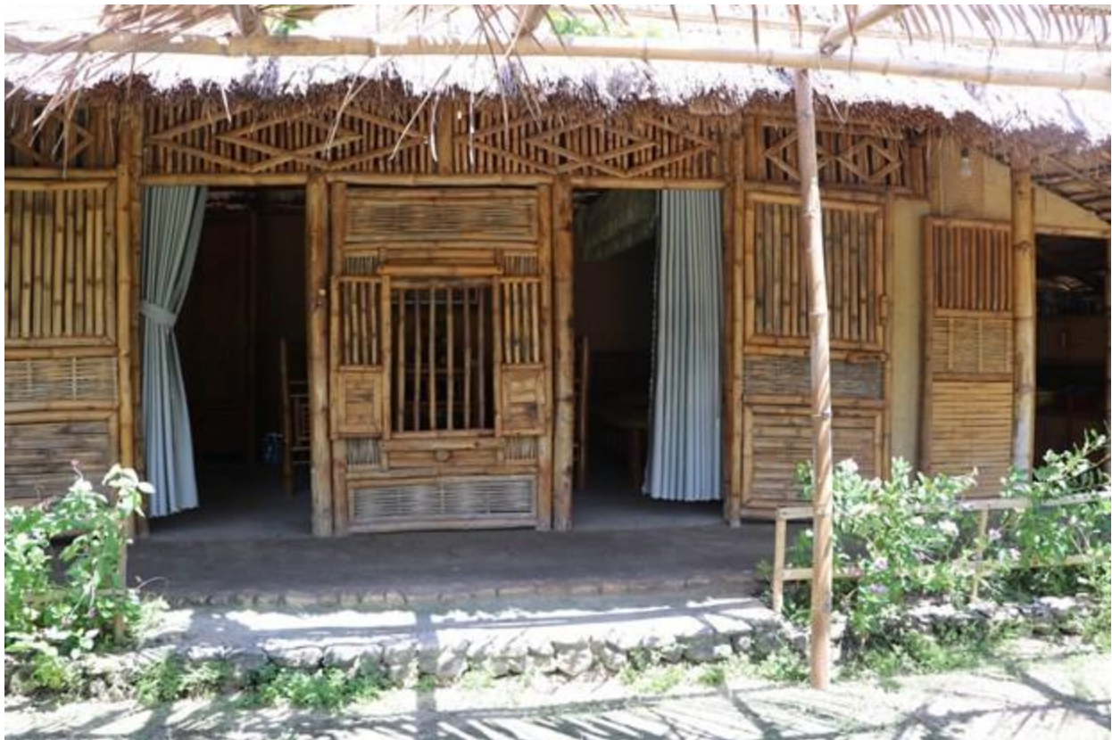
Ngôi nhà bằng tre, mái lợp cọ mọc mạt, đơn giản trong làng cổ Gò Cỏ.
